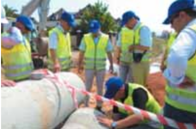
下水道管路の更新現場を視察
