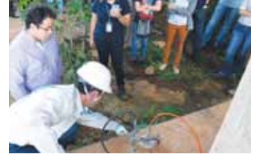
コンクリート構造物の劣化状況を調査(ブラジル)
