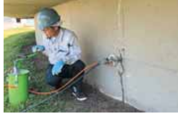
コンクリートひび割れ部分への補修材注入試験(ブラジル)
