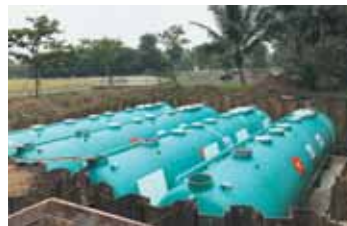
浄化槽の設置工事(ベトナム)
