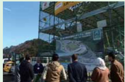
建設中の釜石市鶏住居復興スタジアムを視察
