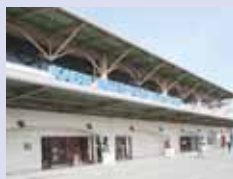
アフガニスタンでの国際空港ターミナル建設
